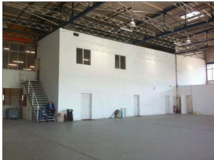
Figure 7 : Prise de vue photographique de l'intérieur du bâtiment (Partie C1 et sanitaires / réunion)
