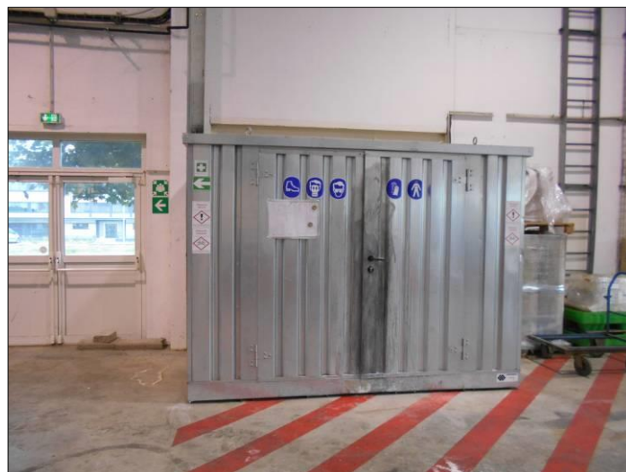
Figure 22 : Prise de vue photographique de l'armoire de stockage des produits chimiques
